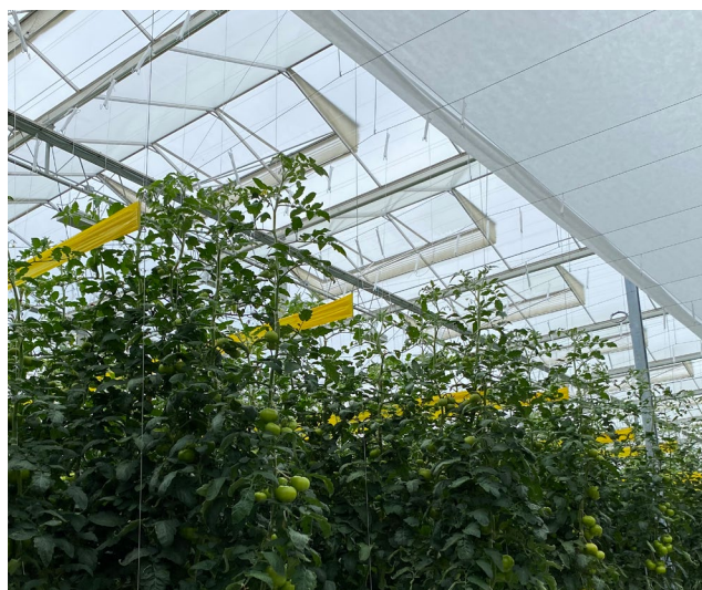
Figure 23. Filets d'exclusion de style accordéon couvrant les événements dans la crête du toit.
