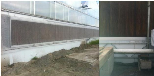
Figure 14 — Schéma d'utilisation des <<cooling pads>>
